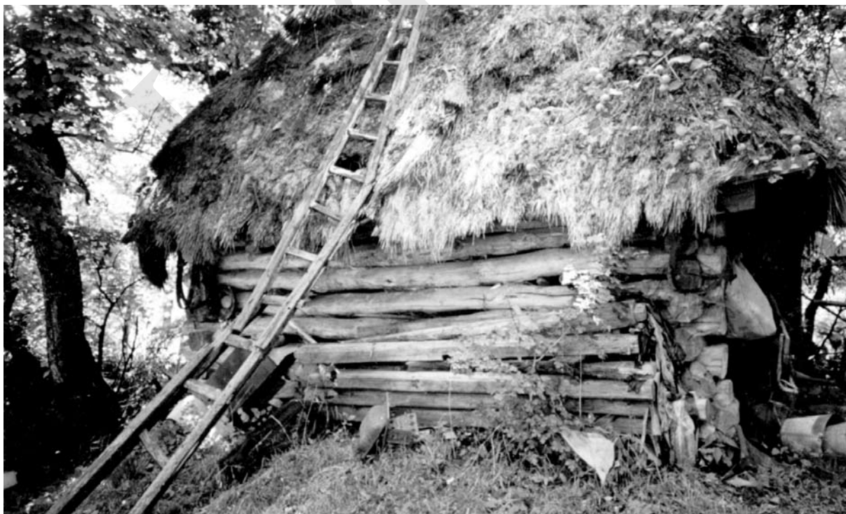
Кліть із с. Стричаво для зберігання овочів у сипанці. Струблена кліть — верхня частина пивниць, дах покрито жупами-(сніпками)
